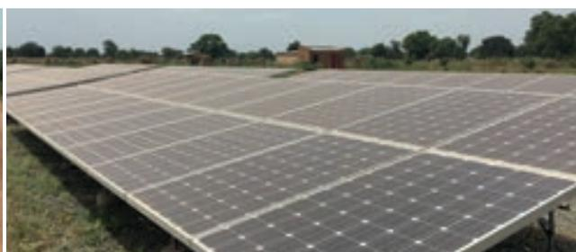
*Le mini-réseau de Bancoumana est l'un des sites les plus récents d'Access. Il est alimenté par 144 panneaux solaires et une batterie d'appoint.*
