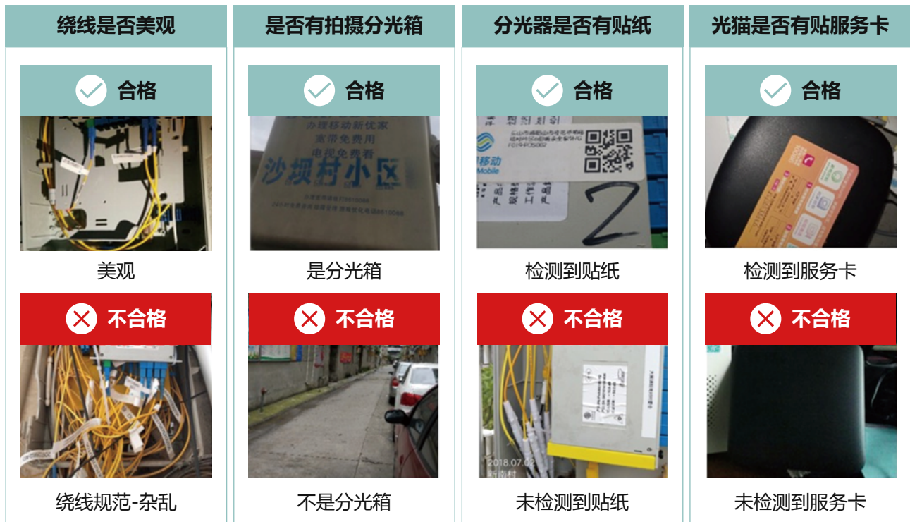
图 18 基础装机工艺质检
